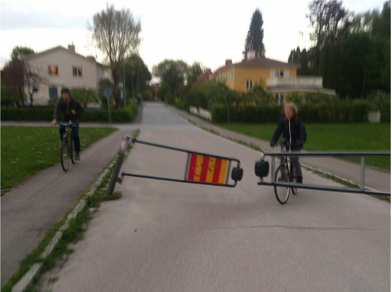
Illustration 1: Den problematiska fällan. OBS cyklist som tar bekvämare väg runt.
